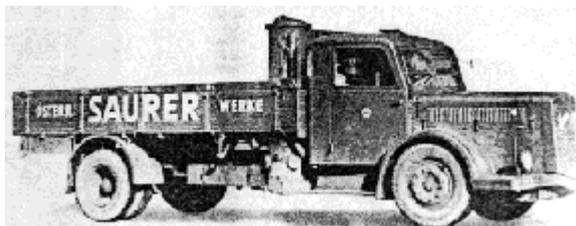
**Рис. 9.** Автомобиль Заурер ВТ 4500 с газогенератором[85].
